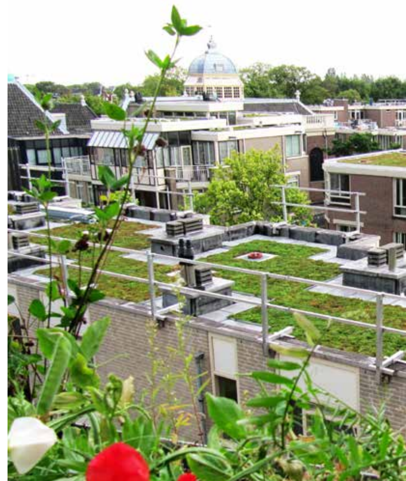
› Groene daken dragen bij aan koeling, wateropslag en biodiversiteit in de stad Foto door Picasdre
