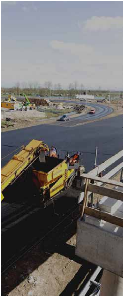
› A9 reconstructie Foto door Heijmans
